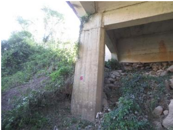
Foto 40: Talude lateral oeste – Encontro Norte.
