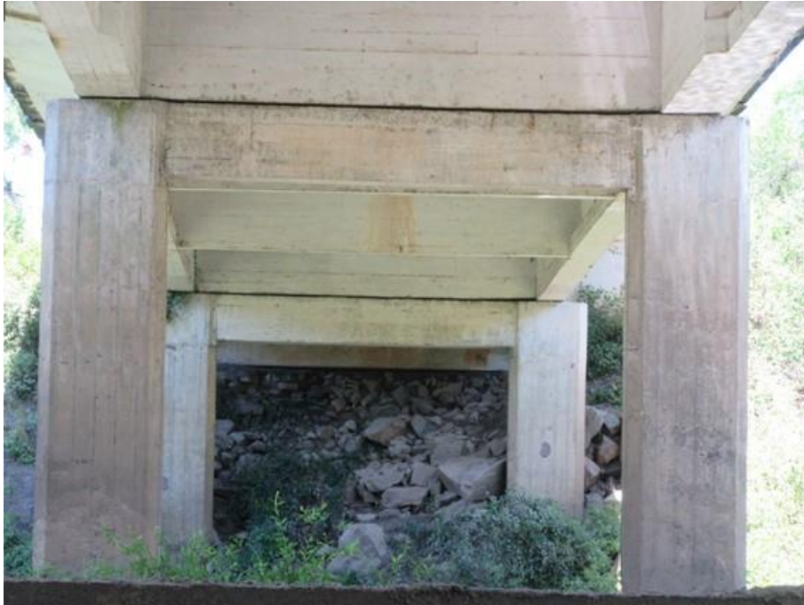
Foto 1 – Sistema estrutural da ponte.
