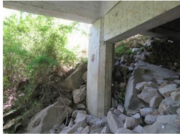
Foto 39: Talude lateral leste – encontro sul.
