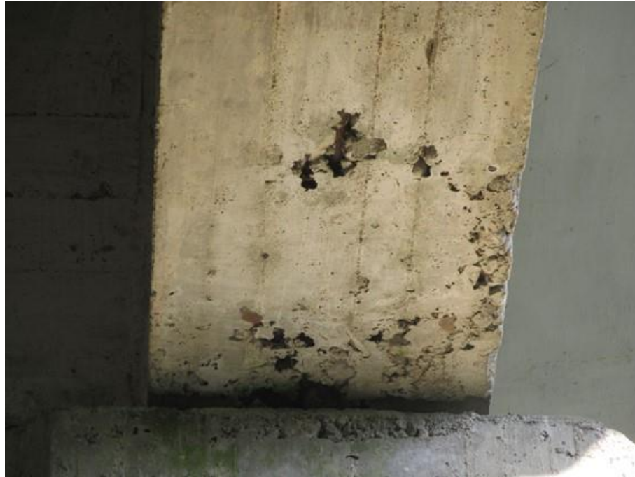
Foto 21 (IMG_1207): Viga Longarina Oeste – Apoio 3 – Face Norte.
