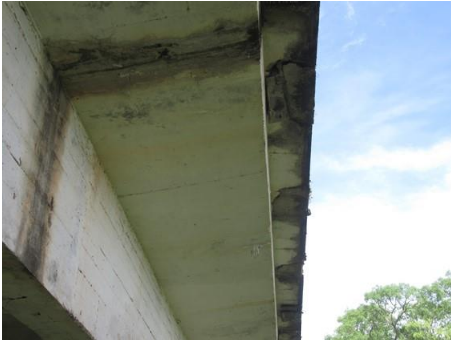
Foto 01 (IMG_1016): Balanço Oeste – Vista Norte/Sul.
