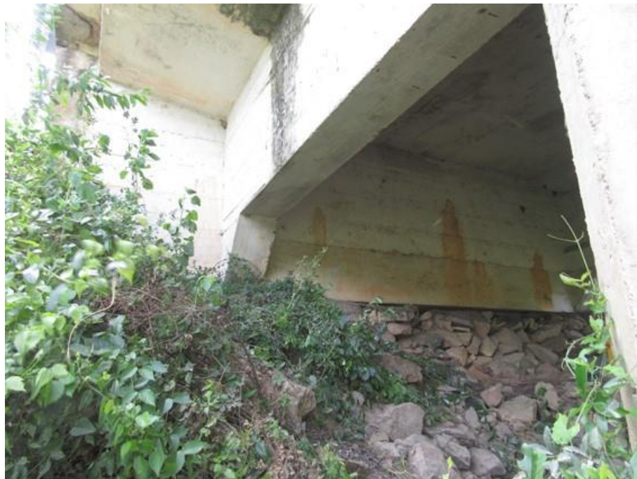
Foto 20 (IMG_1018): Talude sob a obra – Encontro Norte.
