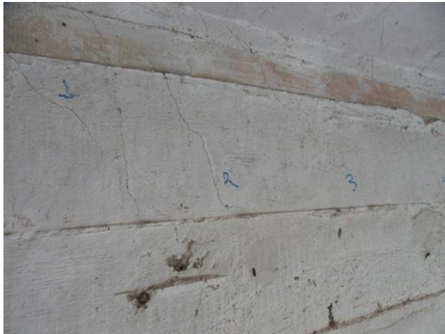
Foto 10 (IMG_1079): Viga Longarina Leste.
