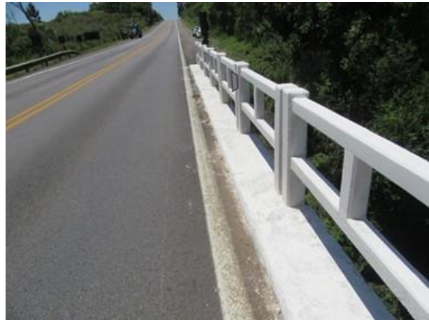
Foto 45: Passeio Leste - Bom estado.
