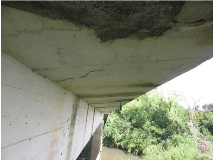
Foto 11 (IMG_1104): Balanço Oeste – Vista Norte/Sul.
