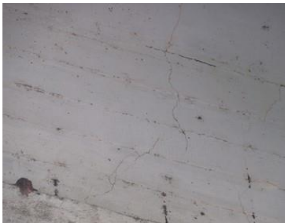
Foto 23: Viga longarina leste - face interna.
