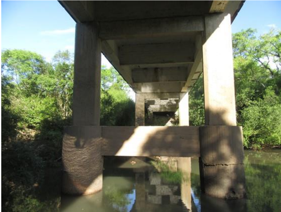
Foto 5: Tubulões contraventados por viga de travamento.
