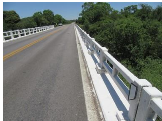
Foto 51: Guarda Corpo Oeste - Bom estado.
