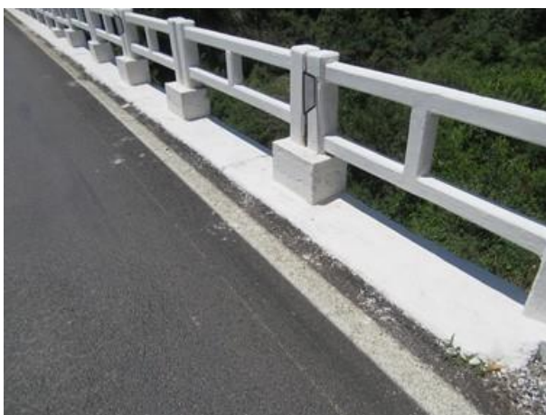
Foto 50: Guarda Corpo Leste – Bom estado.
