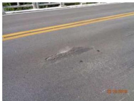
Foto 7. Pavimento deteriorado.
