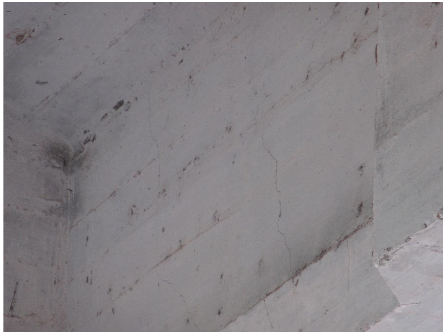
Foto 14 (IMG_1198): Viga Longarina Leste.
