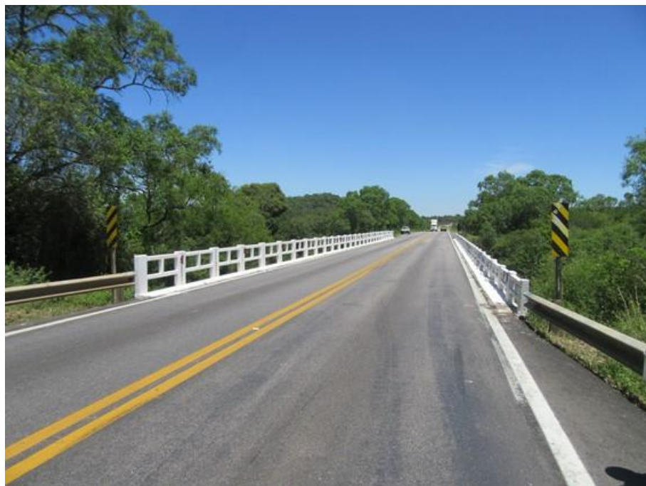
Foto 24 (IMG_1422): Entrada da Obra – Sul/Norte.
