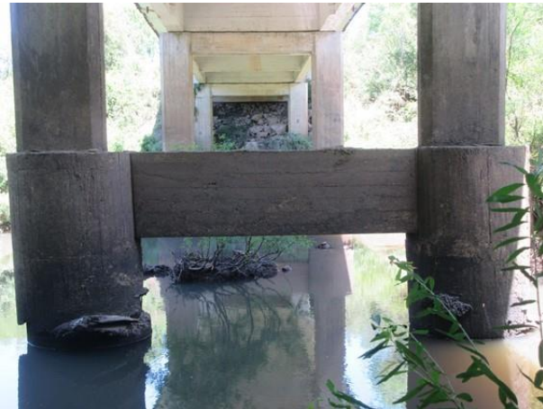
Foto 34: Apoio 2 – Tubulões apoio 1.
