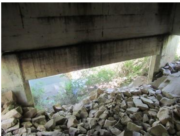
Foto 42: Talude sob obra - Encontro sul.
