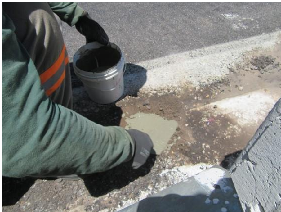
Foto 2: Prospecção – Pista oeste – Sul – Fechamento do furo.
