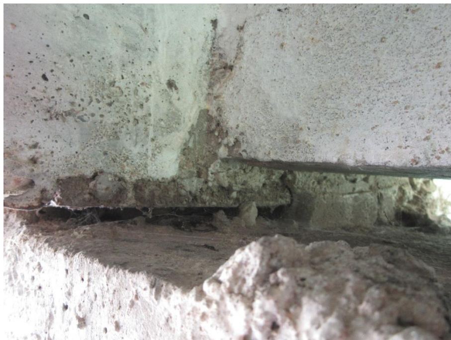
Foto 16 (IMG_1235): Apoio 4 - Leste.
