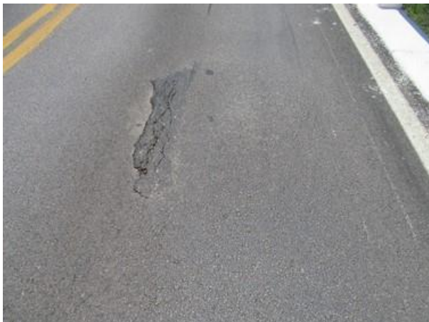
Foto 46: Pista Leste - Panela e Exsudação.
