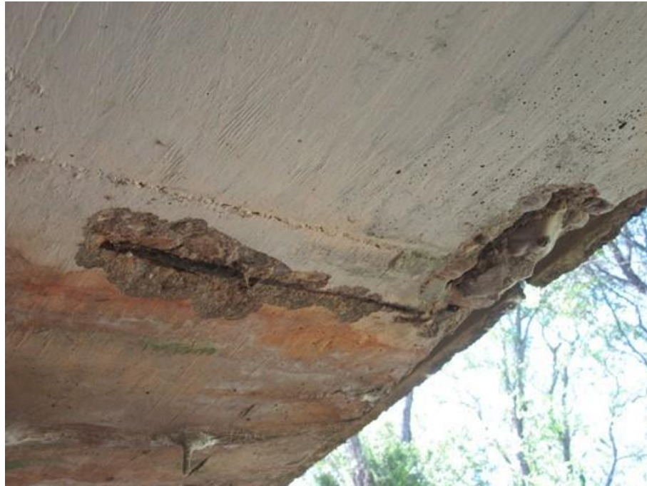
Foto 19 (IMG_1263): Balanço Leste – Vista Sul/Norte.
