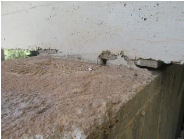
Foto 2: Aparelho de apoio tipo Freyssinet.
