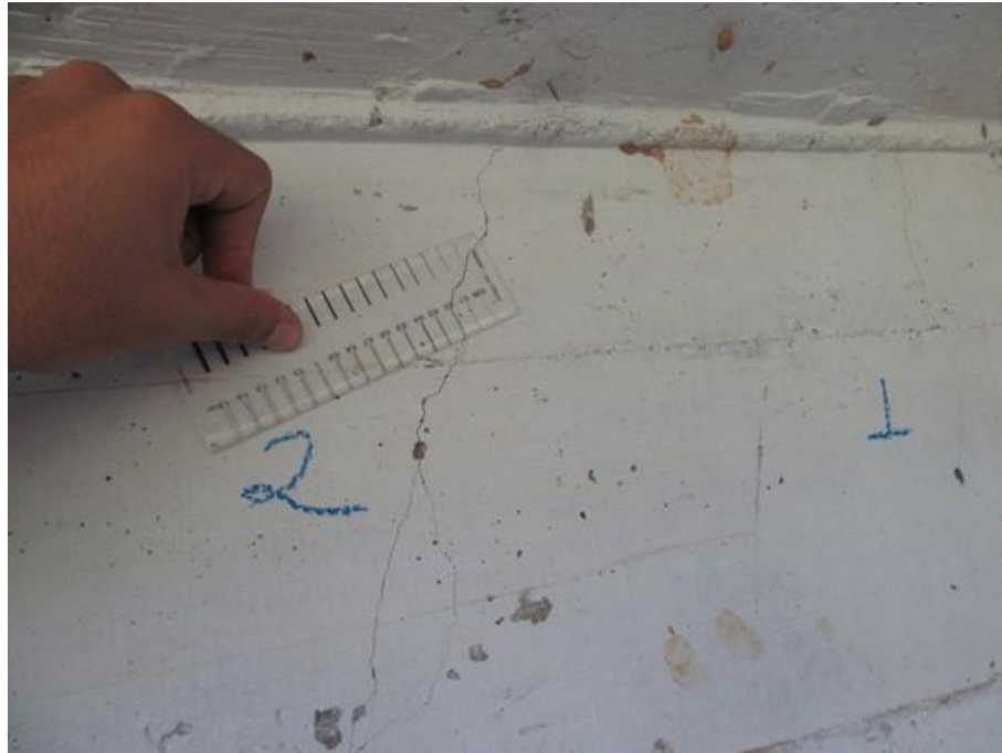
Foto 07 (IMG_1120): Viga Longarina Leste – Face Leste.
