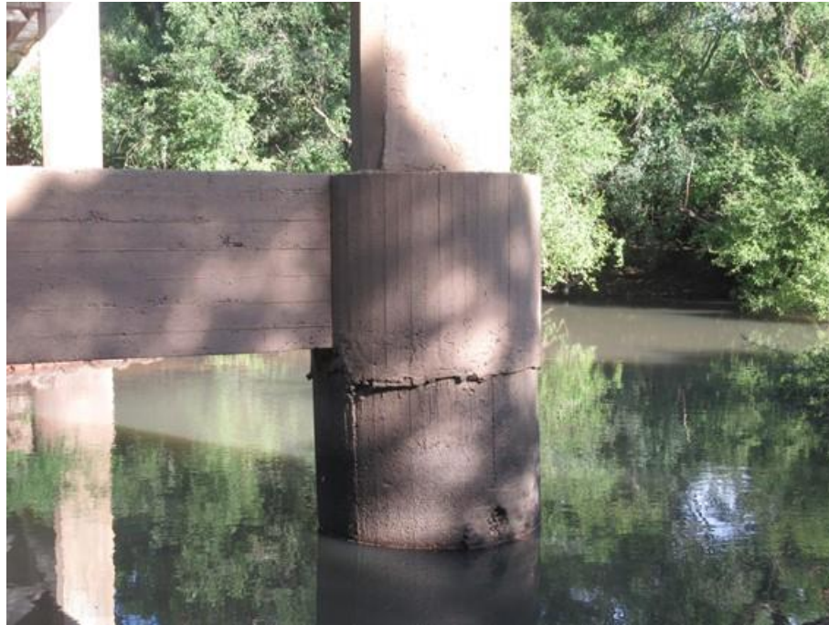
Foto 15 (IMG_1205): Tubulão Oeste - Apoio 3.
