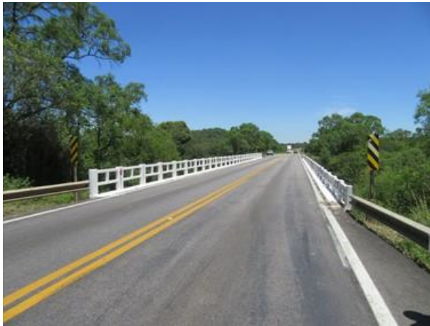
Foto 44: Sinalização horizontal em bom estado.
