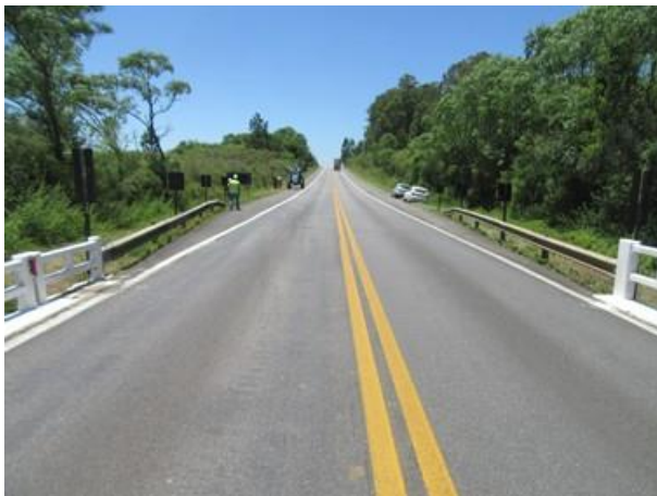
Foto 6: Aproximação sul - vista Pelotas.
