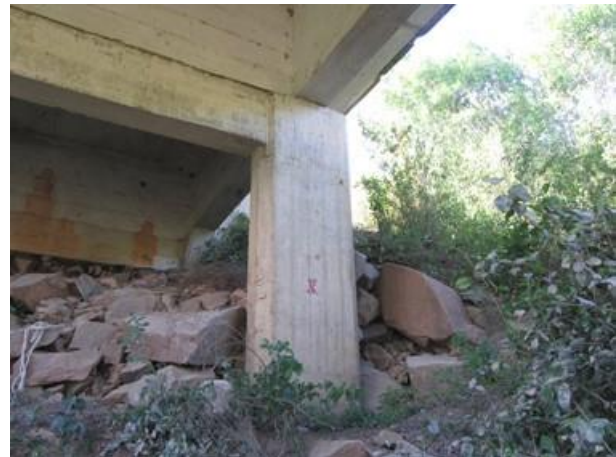
Foto 41: Talude lateral leste – Encontro Norte.
