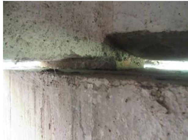
Foto 3: Aparelho de apoio tipo Freyssinet.
