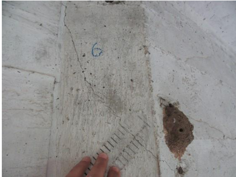
Foto 13 (IMG_1087): Viga Longarina Leste.
