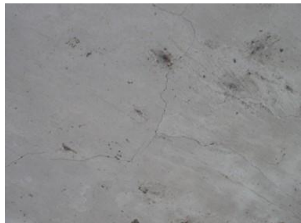
Foto 11: Tabuleiro - Fissuras.
