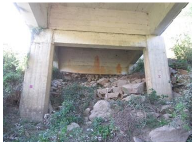
Foto 43: Talude sob obra - Encontro norte.
