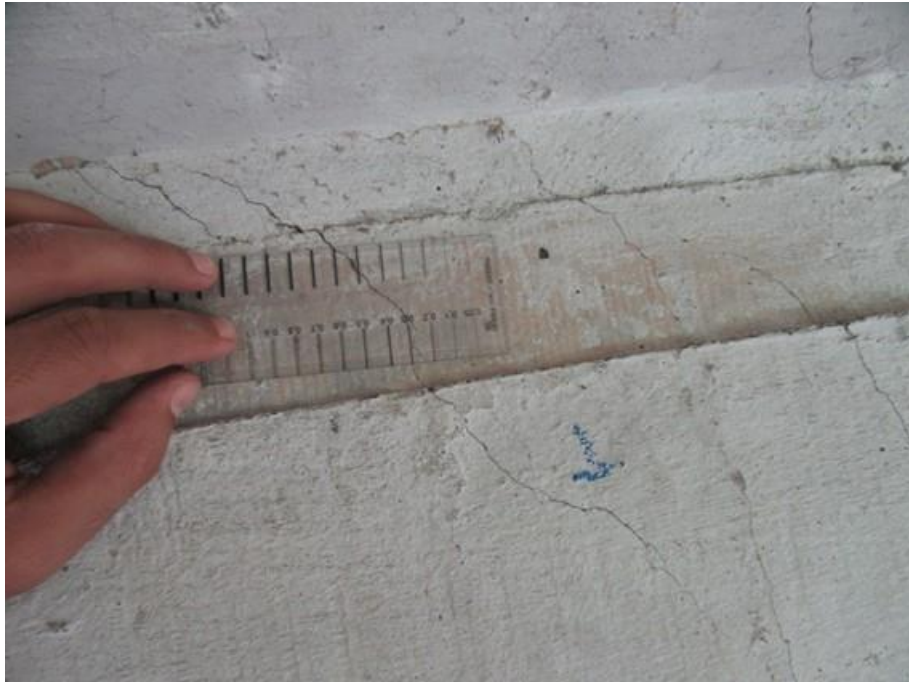
Foto 09 (IMG_1078): Viga Longarina Leste.
