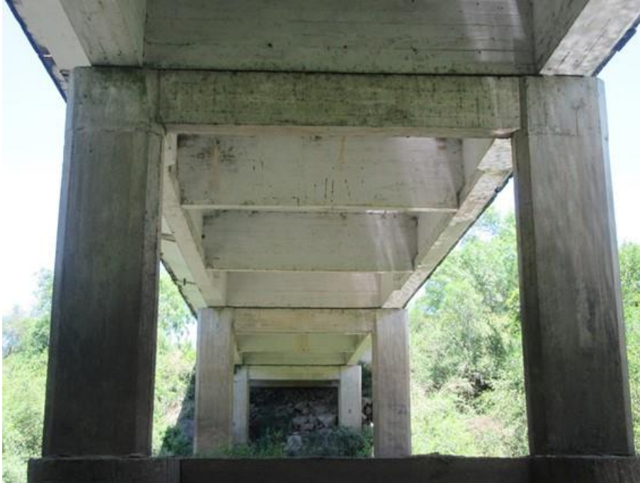
Foto 4: Apoio 1 – Vista Sul/Norte.
