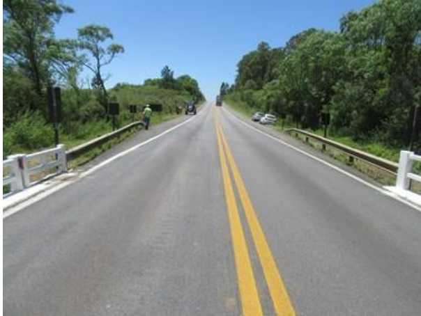
Foto 52: Defensas metálicas - Aproximação norte.
