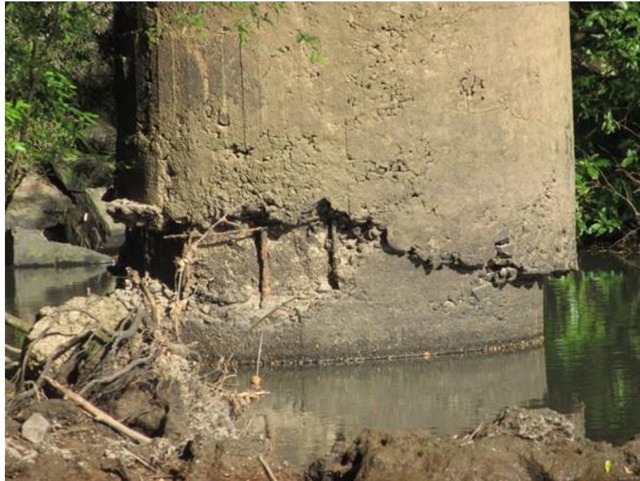
Foto 17 (IMG_1216): Tubulão - Apoio 2 Oeste – Face Norte.
