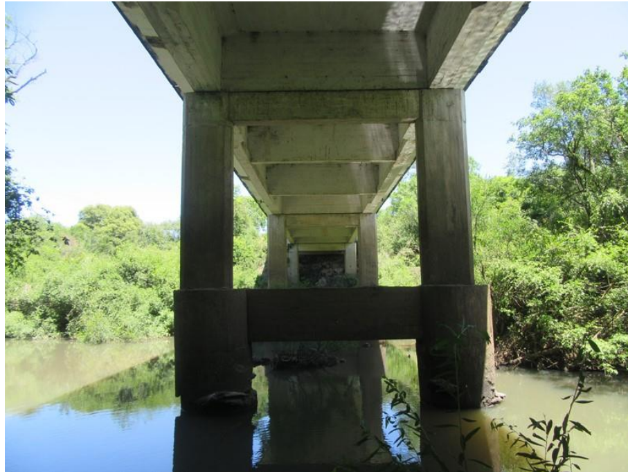
Foto 23 (IMG_1379): Vista Apoio 2 – Sul/Norte.
