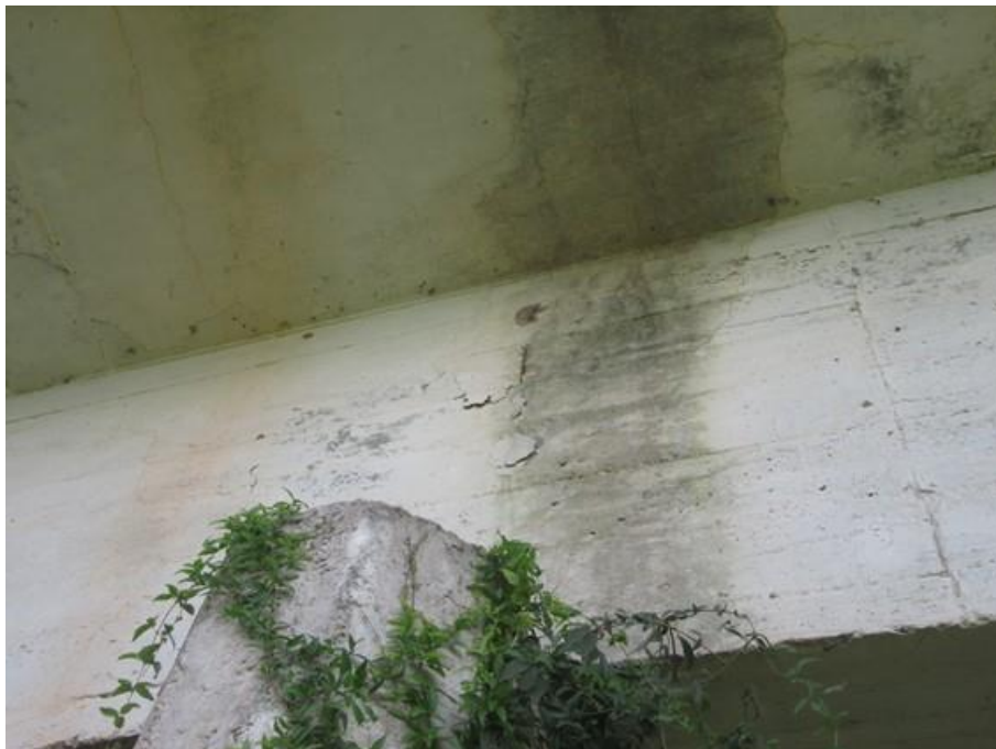
Foto 02 (IMG_1010): Balanço oeste – Apoio 4.
